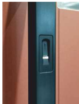
Griff mit integriertem Fingerprint
